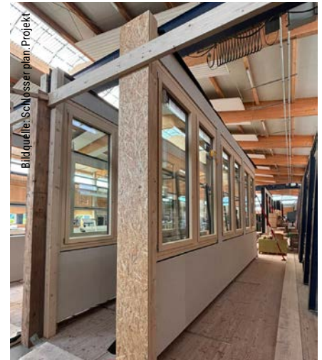
Vollständige Vorfertigung der Holzbauelemente in der Werkhalle, samt Fenster, Leitungen, Anschlüssen und Verbindungsmitteln u.v.m.
