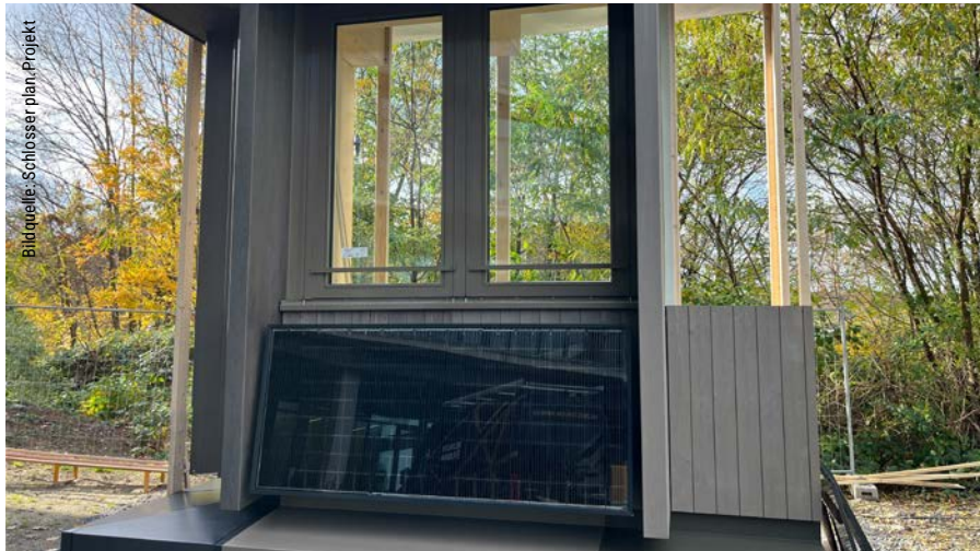
Mit einem 1:1-Mock-up zur Bemusterung, wie hier von einem Ausschnitt der Gebäudehülle mit Fassade, wird die Konstruktion (be)greifbar.
