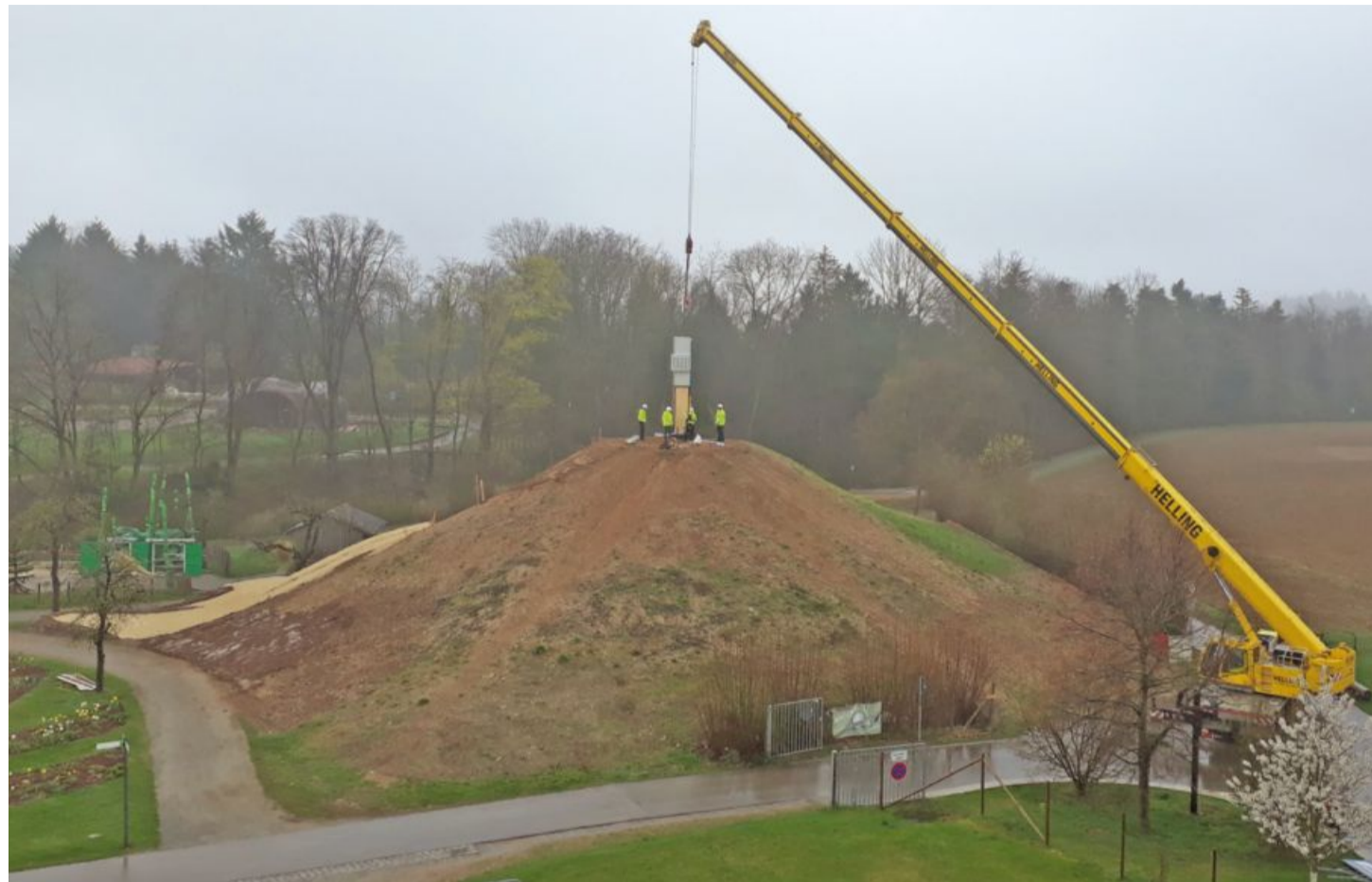
Mit Hilfe eines Autokrans haben Auszubildende des Holzbaubetriebs Schlosser mit ihrem Ausbildungsleiter den Schanzenturm auf dem Hügel im Himmelsgarten aufgestellt. Wo links im Bild bereits Schotter liegt, wird der Auslauf sein. Fotos: arbor walddpädagogik
